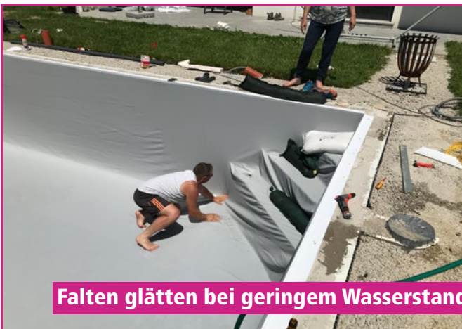
Boden zu den Ecken ausstreifen 2/2
