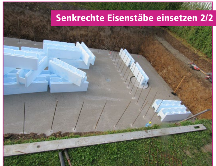
Senkrechte Eisenstäbe einsetzen 1/2
