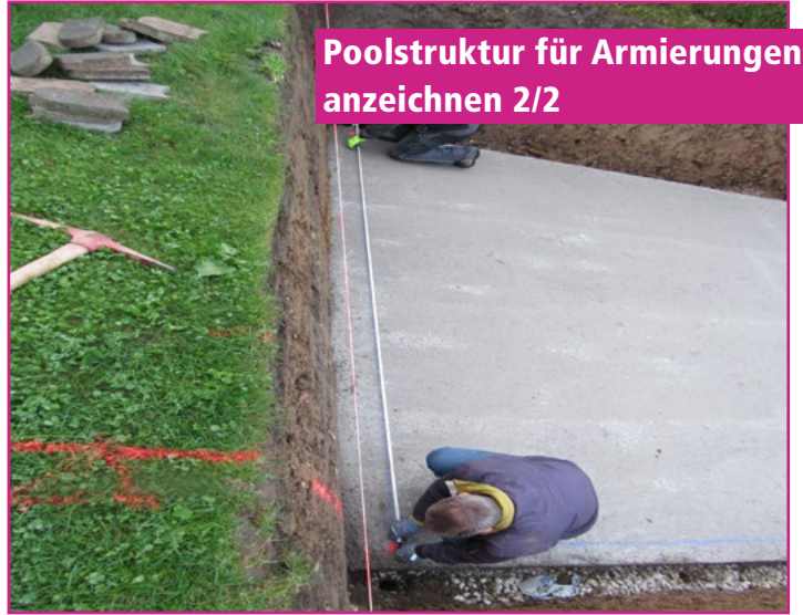
Poolstruktur für Armierungen anzeichnen 1/2
