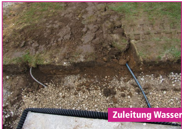
Schotter Hinterfüllung
