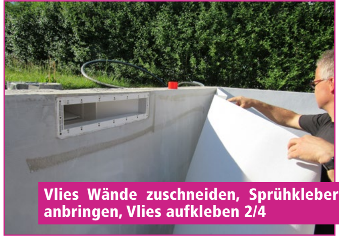
Vlies Wände zuschneiden, Sprühkleber anbringen, Vlies aufkleben 1/4
