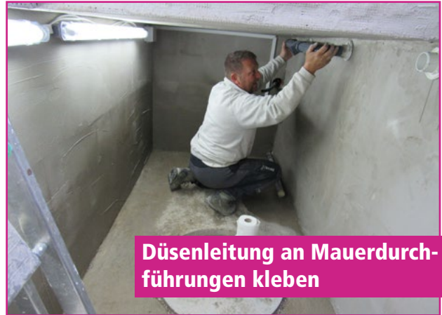
Fittings reinigen vor Ankleben an Mauerdurchführungen
