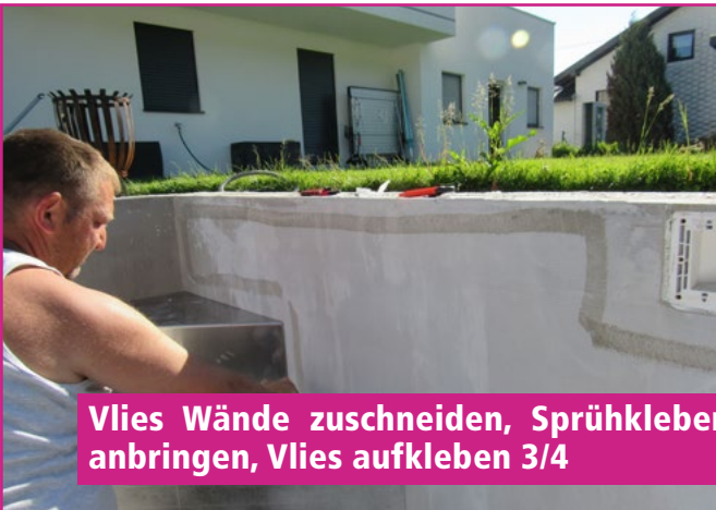
Vlies Wände zuschneiden, Sprühkleber anbringen, Vlies aufkleben 1/4
