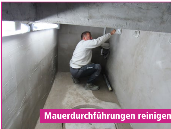
Fittings reinigen vor Ankleben an Mauerdurchführungen
