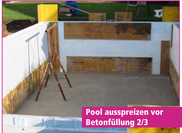
Pool auspreizen vor Betonfüllung 1/3
