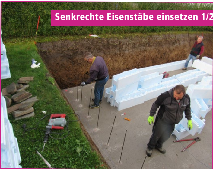
Styroporsteine setzen 1/2
