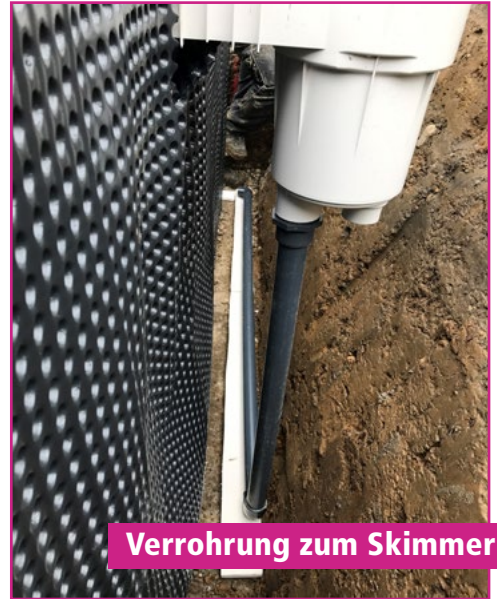
Noppenfolie an Außenseite und Verrohrung über Längsseite
