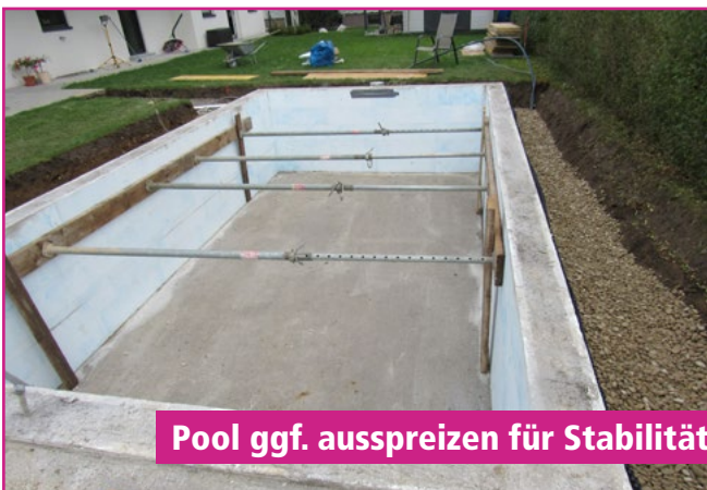
Schotter Hinterfüllung
