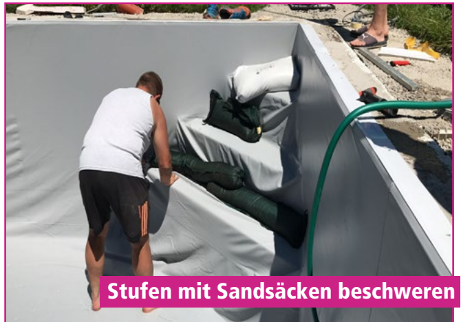
Boden zu den Ecken ausstreifen 2/2
