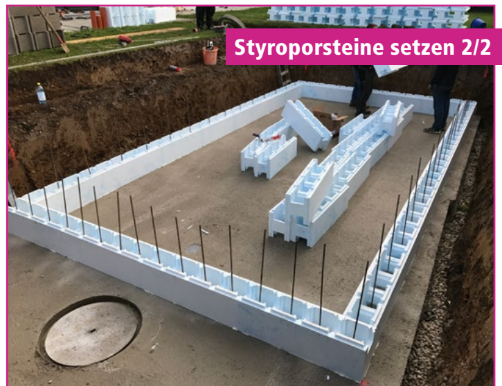
Styroporsteine setzen 1/2
