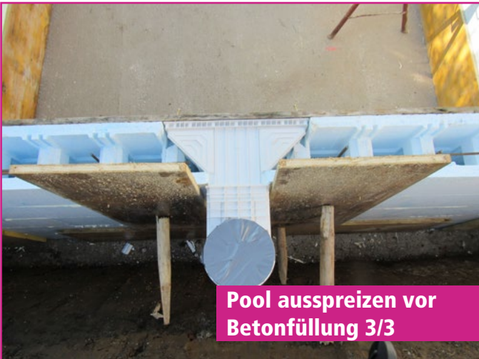
Pool auspreizen vor Betonfüllung 1/3
